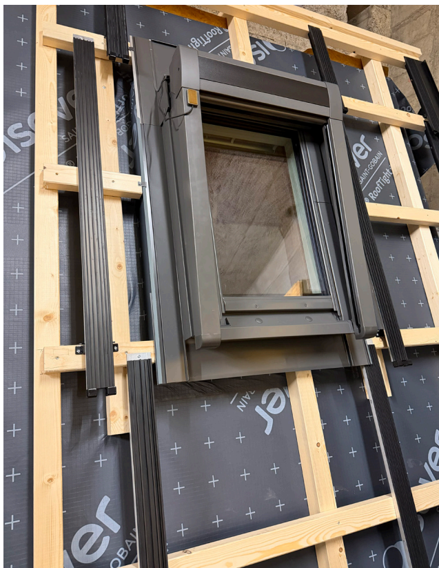
Montage de la sous-construction LEVEL up (crochets et rails)
