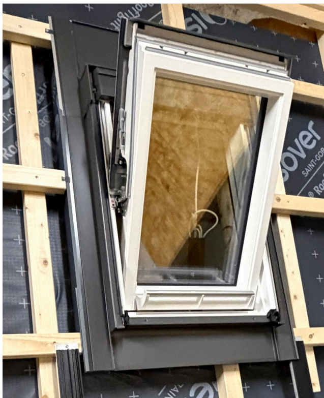
Cadre de raccordement ODL entièrement monté pour une hauteur d'installation standard.
