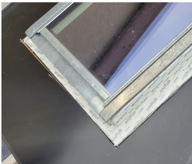
Dachfenster mit NICER X Aluverbundmodul integriert. Ausschnitt noch nicht bauseitig abgedichtet.
