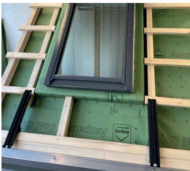
Applicare i ganci Megasol MATCH Slate secondo le indicazioni di progettazione o secondo una disposizione personalizzata.
