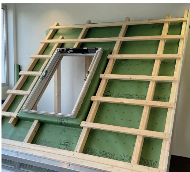
Applicare il nastro sigillante per chiodi sulla controstaffa (indicazioni del produttore della membrana sottotetto) e installare secondo il piano dei listelli.
