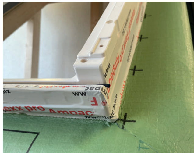
Applicare il nastro sigillante per chiodi sulla controstaffa (indicazioni del produttore della membrana sottotetto) e installare secondo il piano dei listelli.
