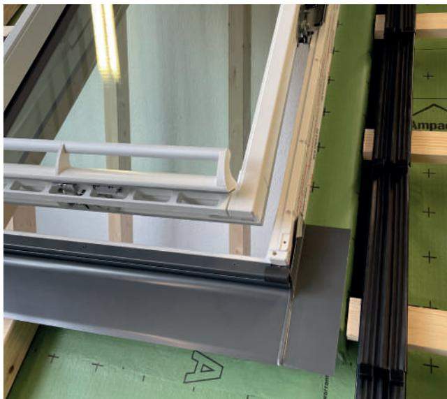
Montage de la partie inférieure du raccord VELUX (type ODL) et mise en place de la tôle de solin PLUS (2a)
