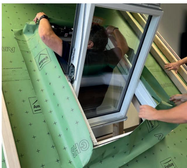
Placer le tablier pré-confectionné par le client. Alternativement, monter le lé de sous-toiture de manière conventionnelle sur le cadre de montage selon les instructions du fabricant.
