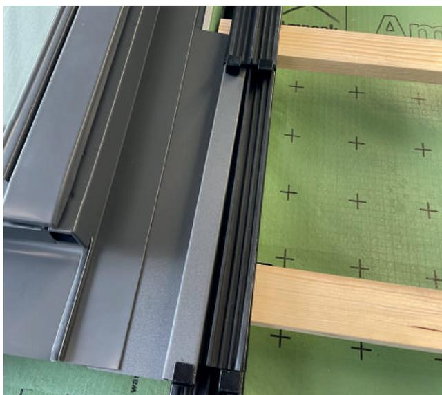
Mise en place des tôles de fermeture par le client. Commencer par "Tôle de transition bas L & R pour MK06-SK06-MK10-SK10". Dessins des tôles à la fin du document.
