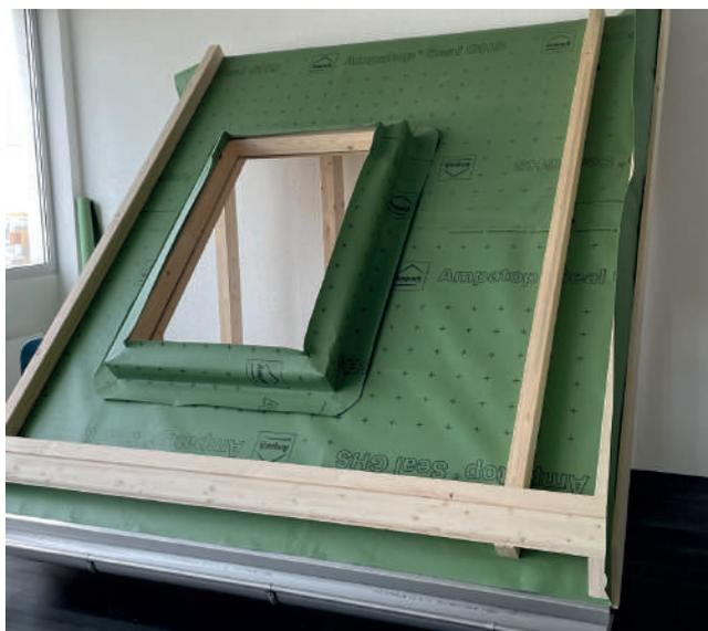
Contrôler l'alignement du sous-cadre par rapport au chéneau. Répartir le contre-lattage et le compléter.
