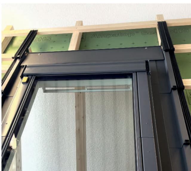
Fixation de la tôle d'entrée en haut avec des vis de couvreur
