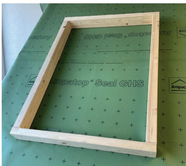
Placer le cadre de montage. Répartition selon les dessins techniques Megasol MATCH Slate. Aligner le cadre auxiliaire, l'incliner et le visser.
