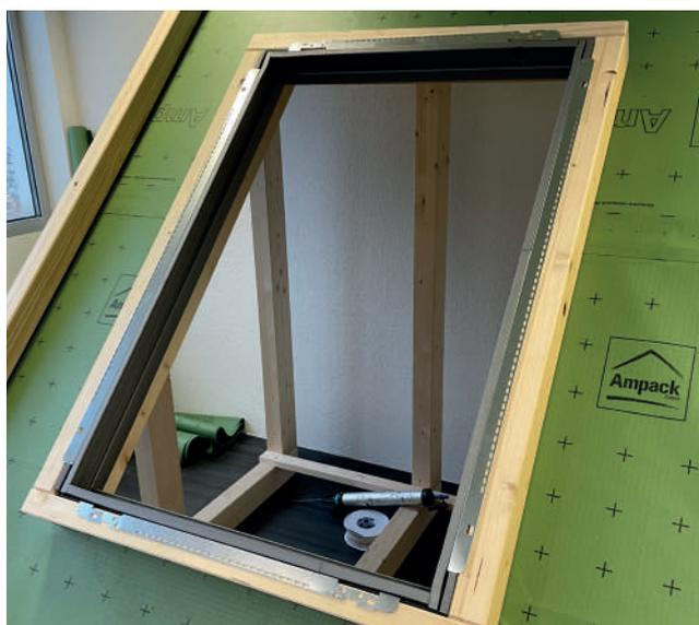
Assembler les cadres isolants BDX et couper et placer les languettes sur les 4 côtés en respectant les angles.
