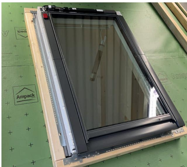
Orienter la fenêtre de toit dans "l'angle" et "l'équerre" et la visser dans le cadre auxiliaire.
