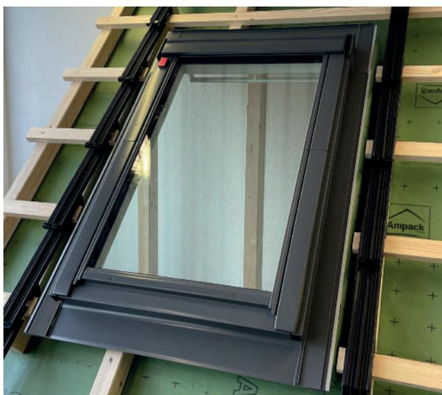
Raccord d'étanchéité ODL entièrement monté.
