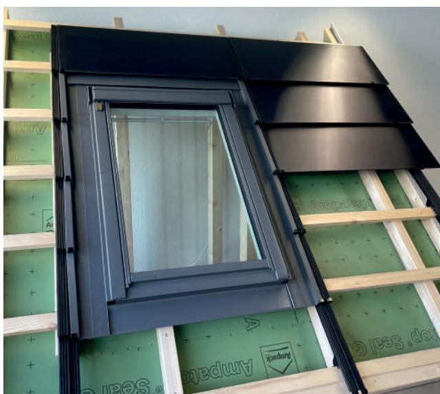
Mise en place des modules Megasol MATCH Slate.
