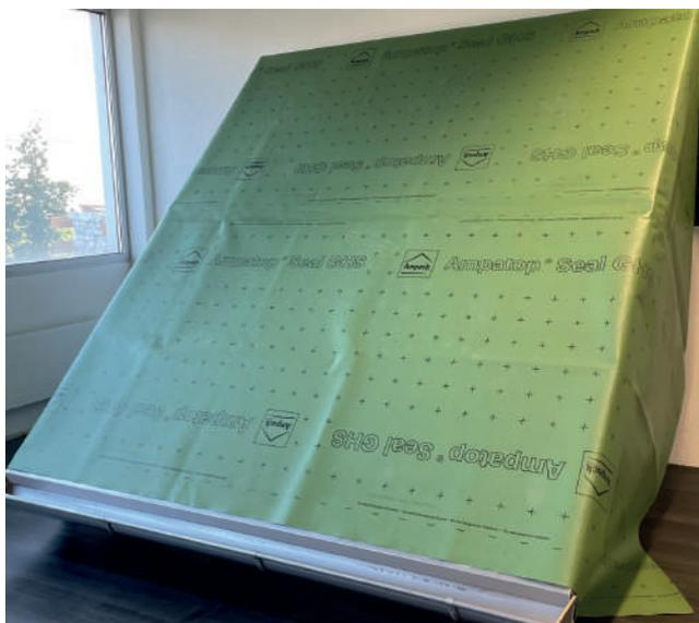
Appliquer le lé de sous-toiture sur toute la surface. (Lé de sous-toiture recommandé par Ampack : Ampatop® Seal GHS, autorisé pour 6 mois d'exposition aux intempéries).
