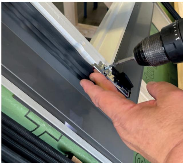
Fixer les drains 2a et 3a au raccord.
