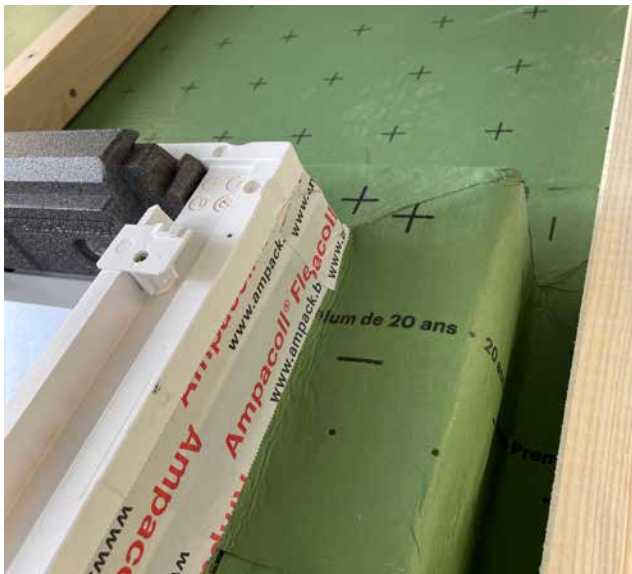
Abkleben der Unterdachbahn am Dachfenster.
