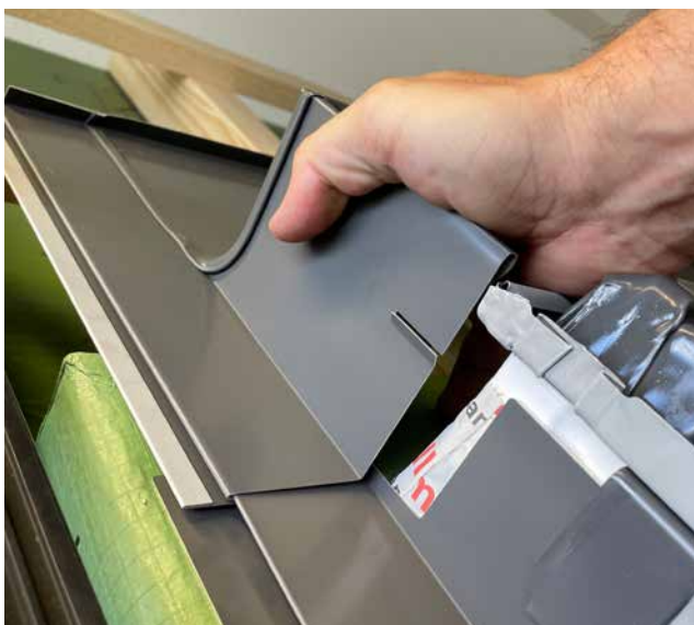
Kopfstück Eindeckrahmen in den seitlichen Falz einschieben.
