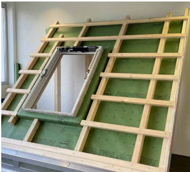
Konterung mit Nageldichtband versehen (Richtlinien Hersteller Unterdachbahnen) und gemäss Lattungsplan montieren.
