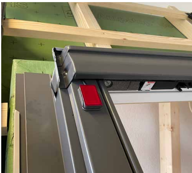
Montage des Markisenkastens.
