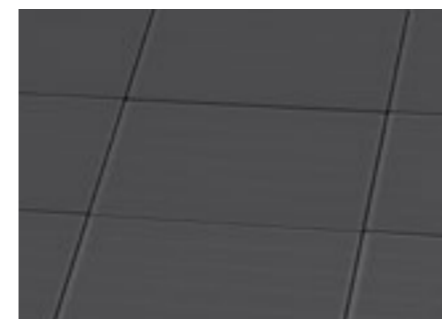
7 Entièrement posé, le système NICER est une couverture de toit étanche.
