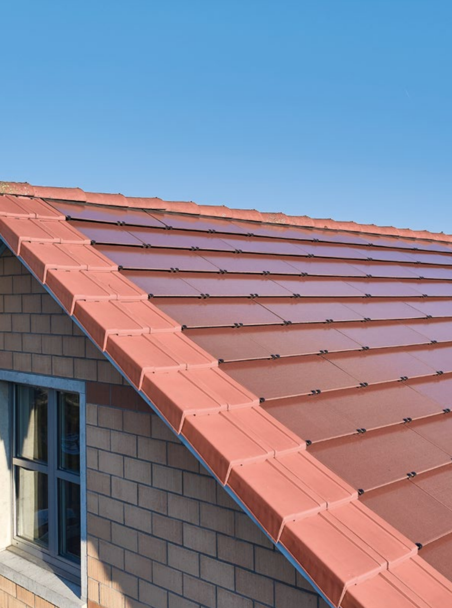
▲ Immeuble d'habitation à Zurich | MATCH Tile système intégré
