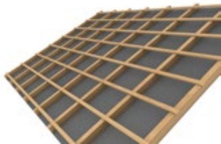
1 Preparare la listonatura del tetto
