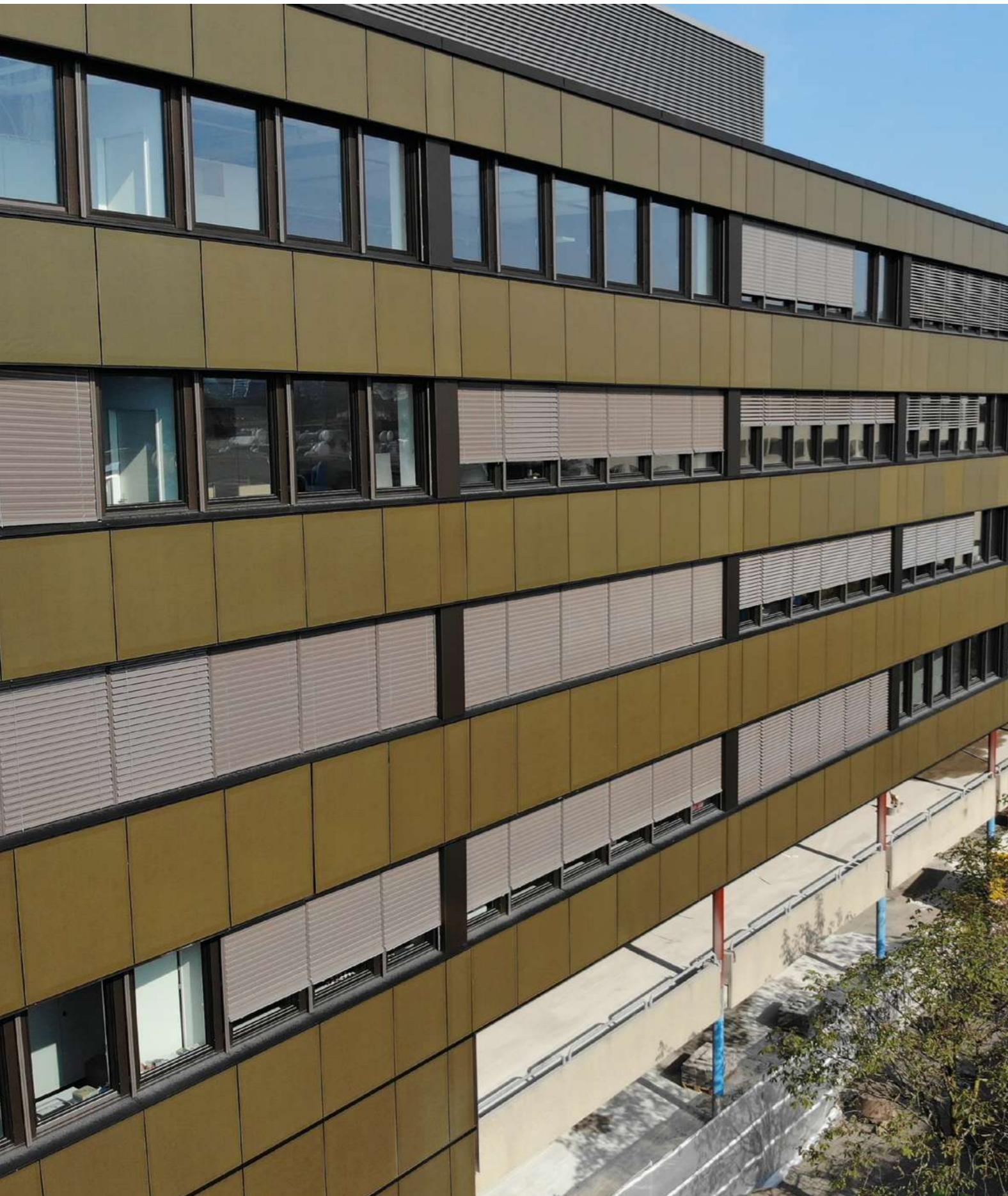
▲ Coop Letzipark Zürich | Facciata solare con moduli in colore speciale
