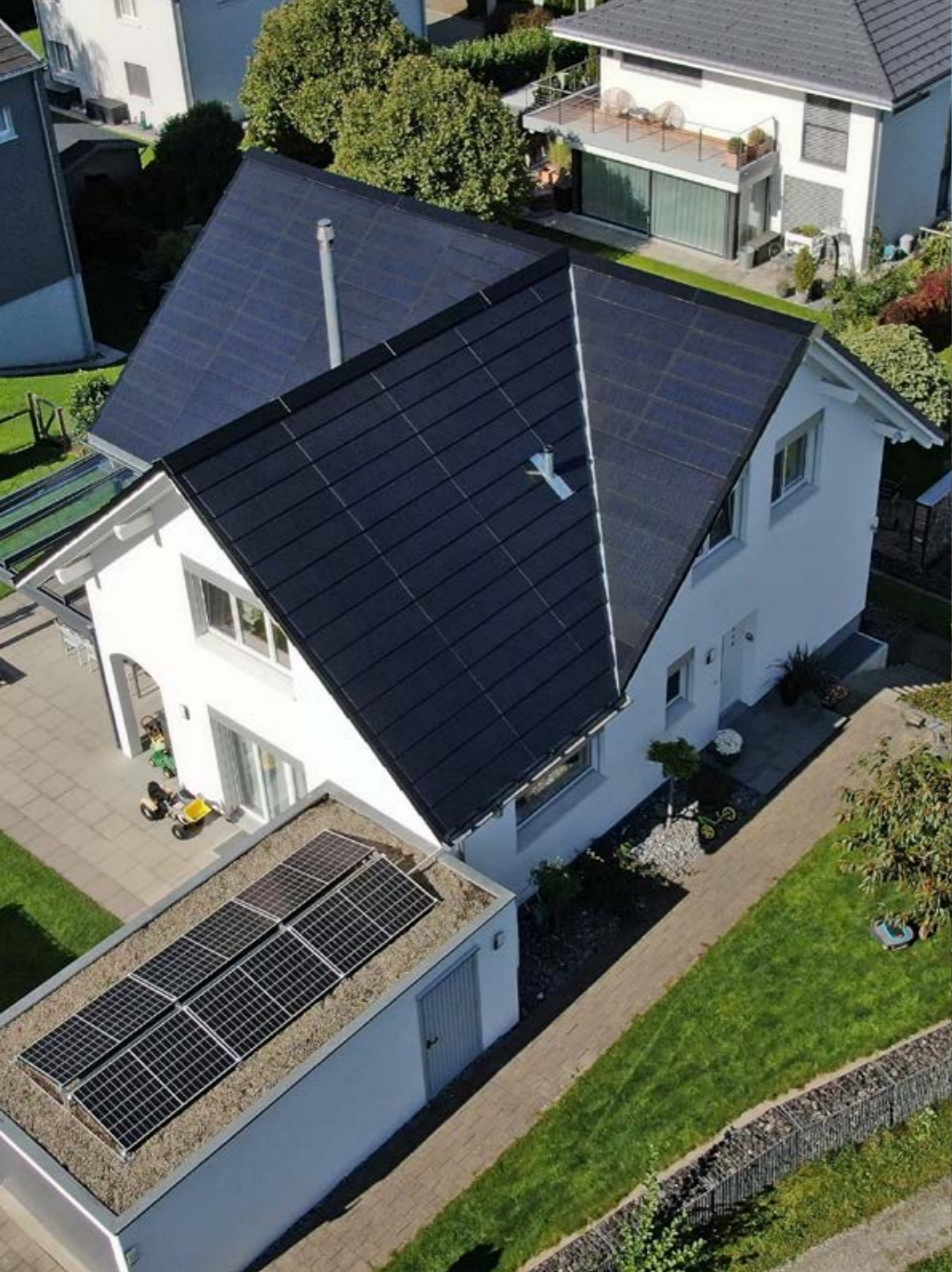
▲ Casa indipendente a Waldkirch | MATCH Slate Sistema sul tetto, accanto ad esso sistema sul tetto del garage
