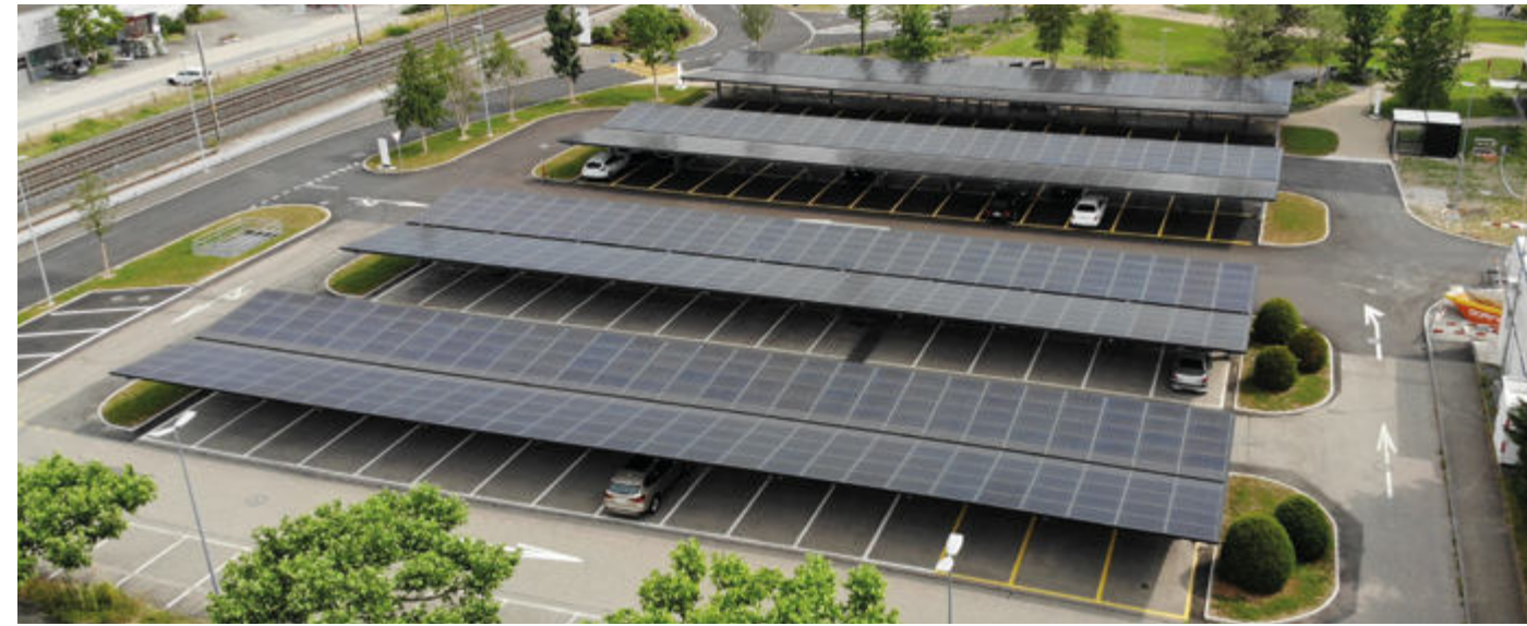
▲ Carport à Ebikon | Puissance de l'installation : 328 kWc
