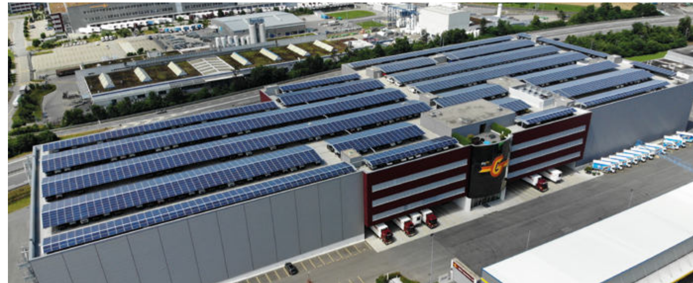
▲ Carport à Dagmersellen | Puissance de l'installation : 1.8 MWc
