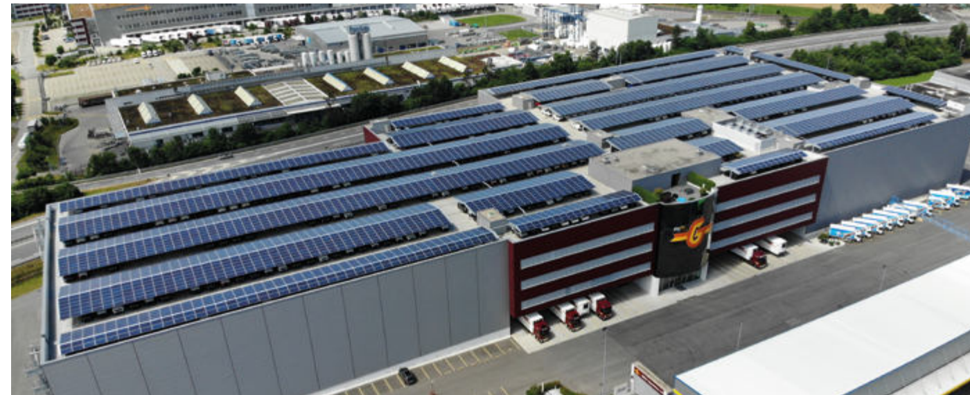
▲ Carport in Dagmersellen | Anlagenleistung: 1.8 MWp
