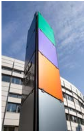
▲ BIPV-Demonstrations-Steile Bild: Fraunhofer ISE
