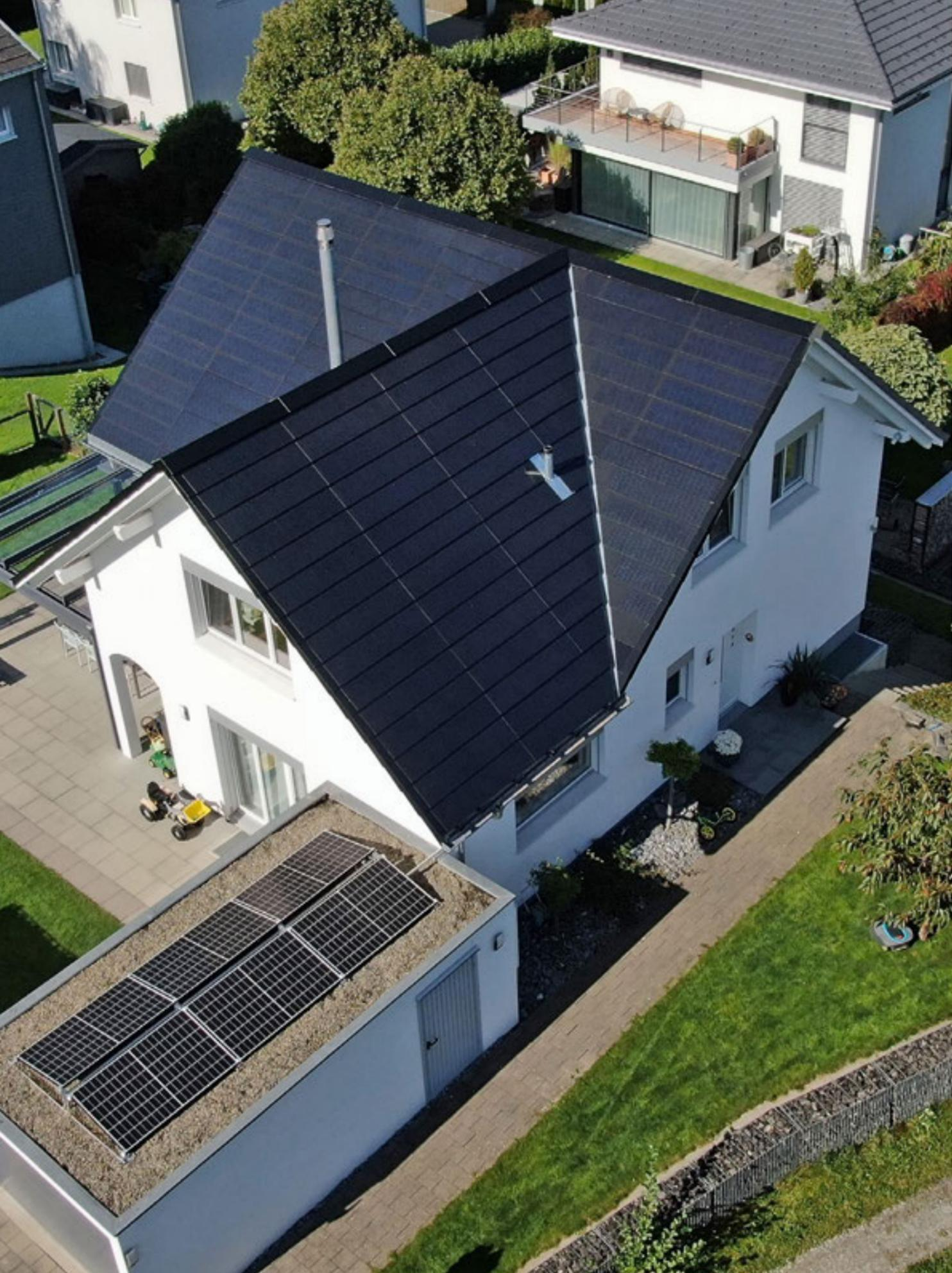
▲ Maison individuelle à Waldkirch | Installation MATCH Slate intégrée à la toiture, à côté de l'installation sur toiture du garage
