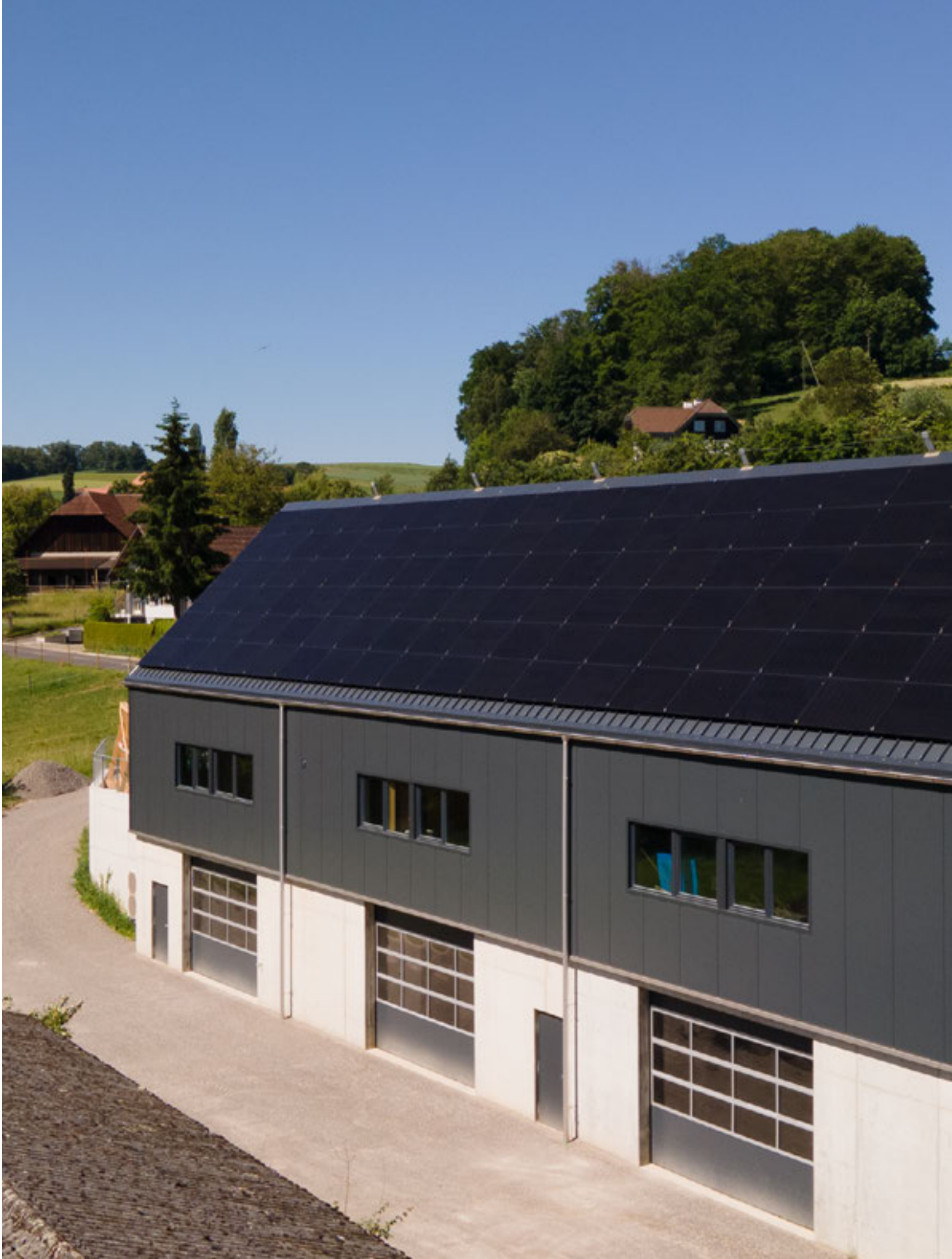
▲ Gewerbehalle in Buchegg | LOCKUP Roof | 182 m² | 36 kWp
