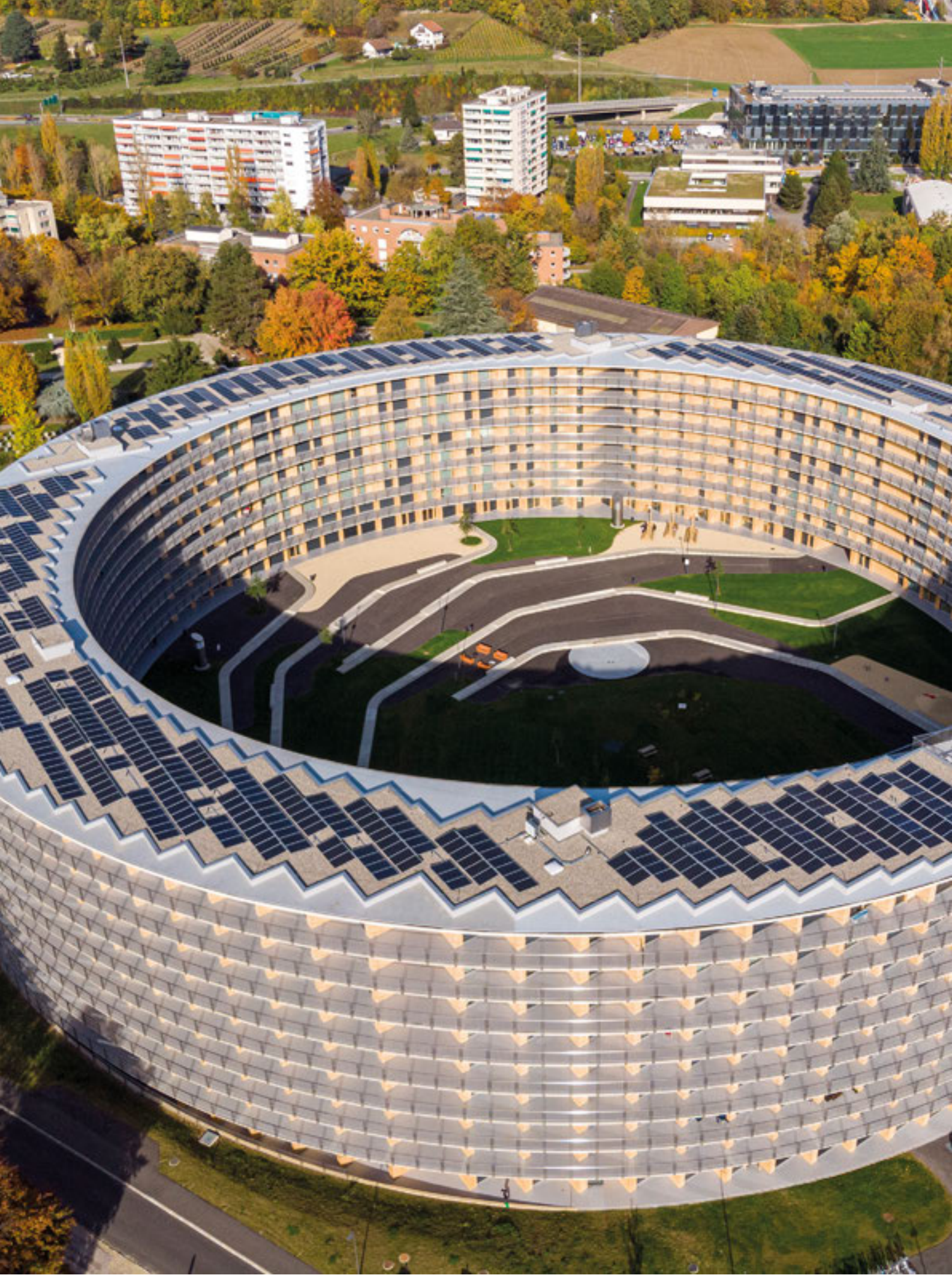
▲ Vortex Campus in Lausanne | Hochleistungsmodule mit LOCKUP Flatport | 330 kWp | Bild: Université de Lausanne
