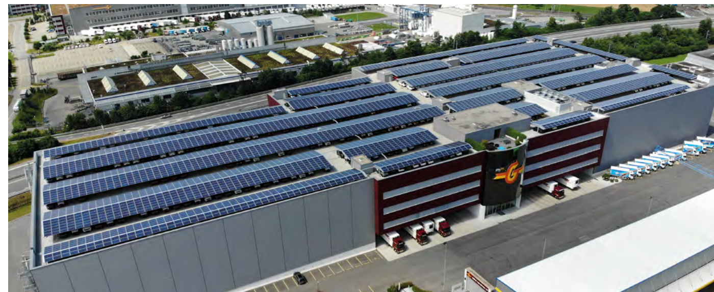
▲ Carport in Dagmersellen | Anlagenleistung: 1.8 MWp
