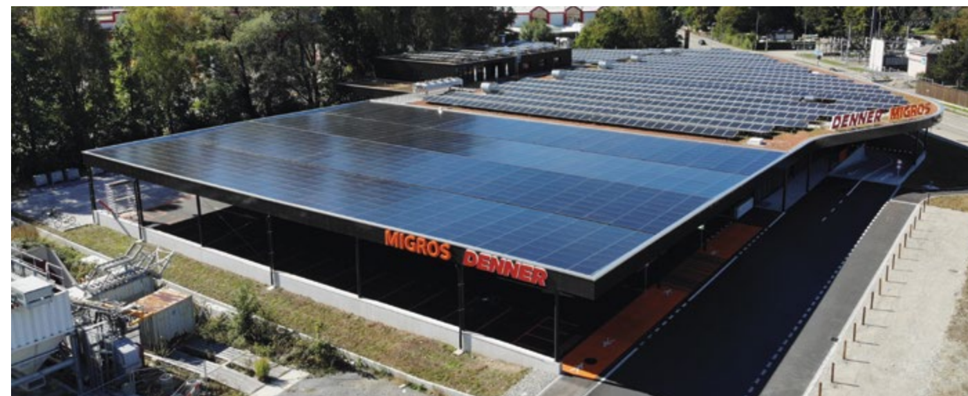
▲ Carport in Schlieren | Anlagenleistung: 294 kWp
