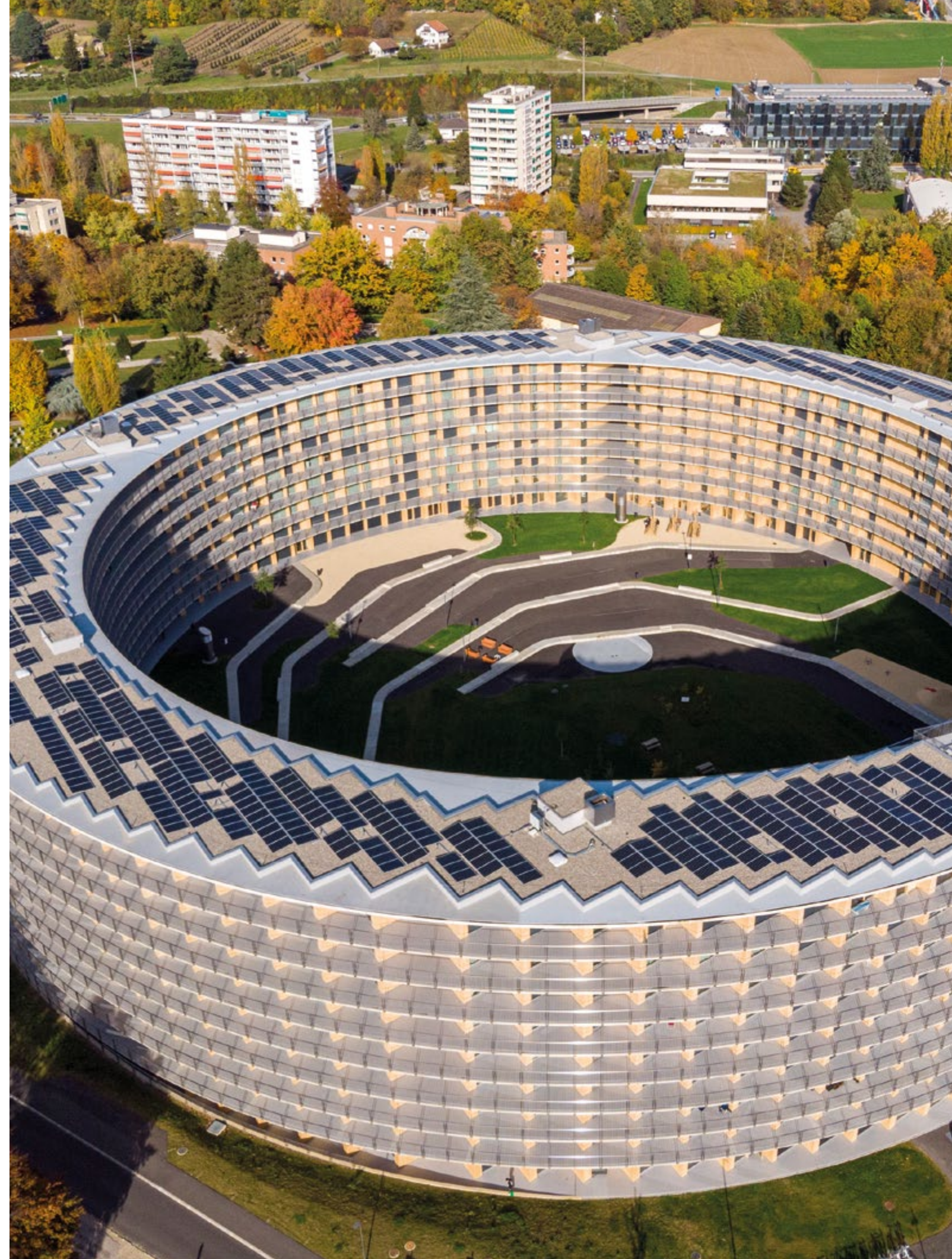
▲ Campus Vortex à Lausanne | Panneaux de haute puissance avec LOCKUP Flatport | 330 kWc | Photo : Université de Lausanne
