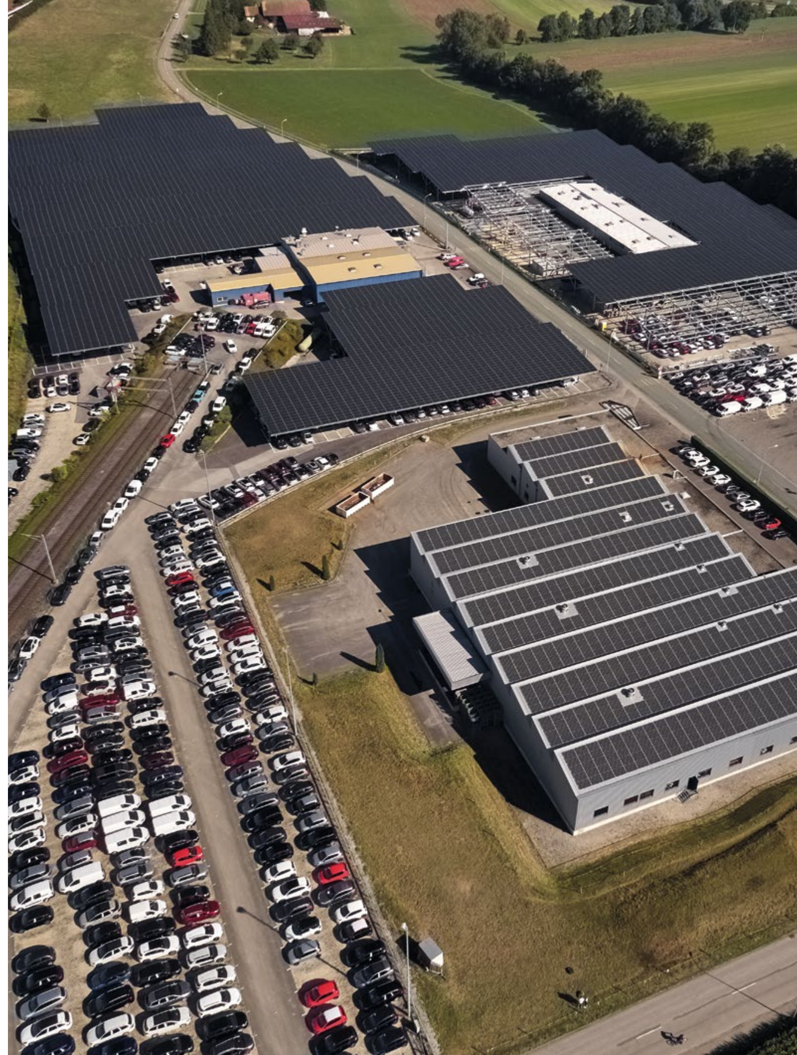
▲ Carport Gefco à Courgenay | 43'000 m 2 | 6.84 MWc
