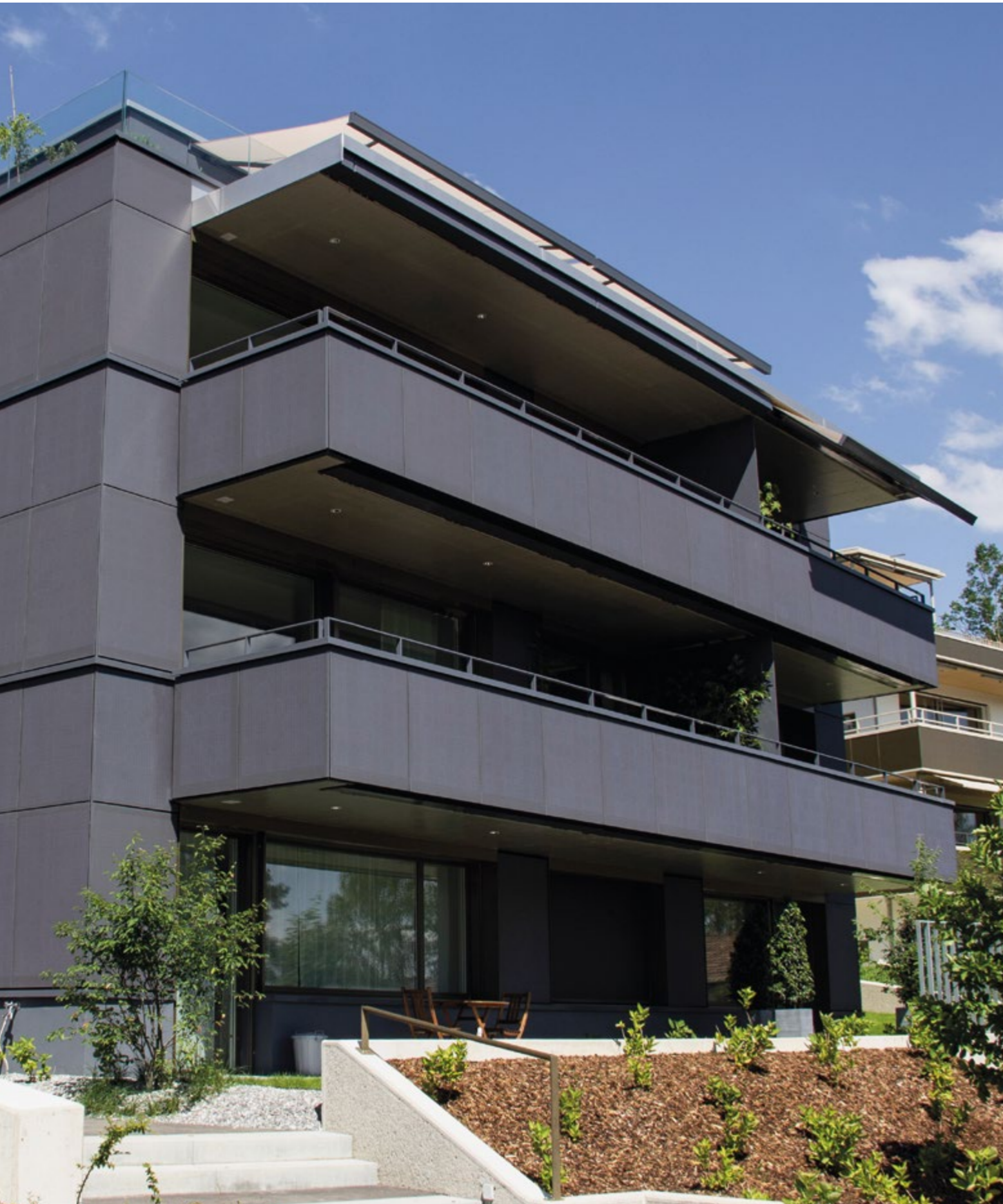
▲ Immeuble collectif à Zurich | Façade solaire à l'aspect carbone | Diplôme du Prix Solaire Suisse 2019
