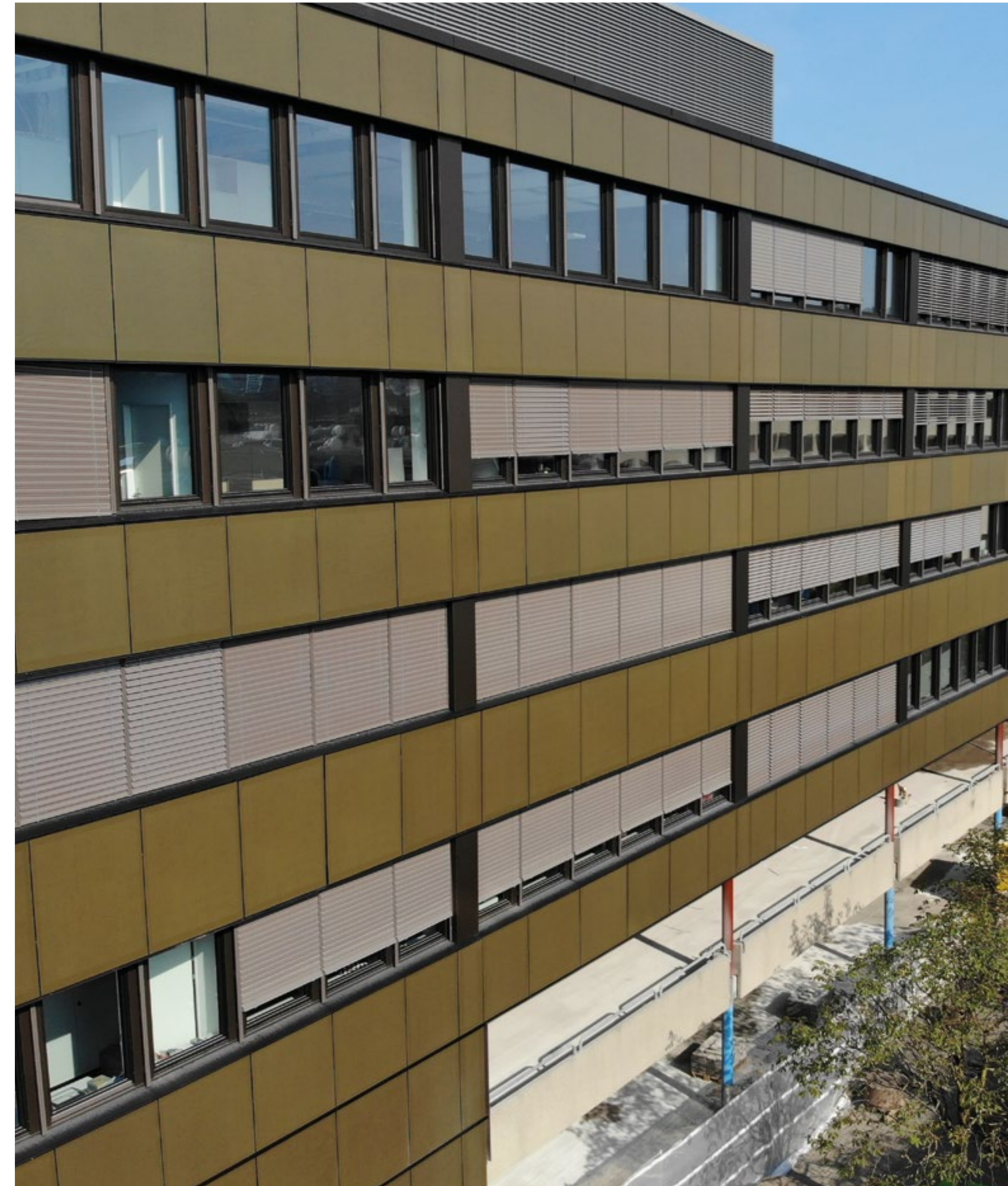
▲ Coop Letzipark Zurich | Façade solaire avec des panneaux de couleur spéciale
