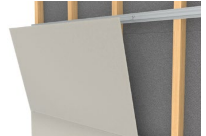
2 Positionner le panneau, inclinaison possible pour câblage.
