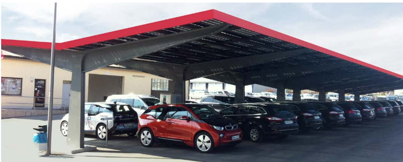
▲ Carport in Zandt, DE | Anlagenleistung: 67.3 kWp
