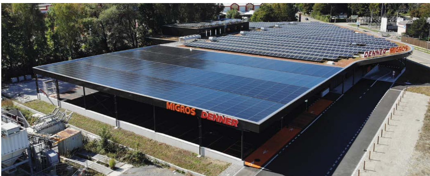
▲ Carport in Schlieren | Anlagenleistung: 294 kWp
