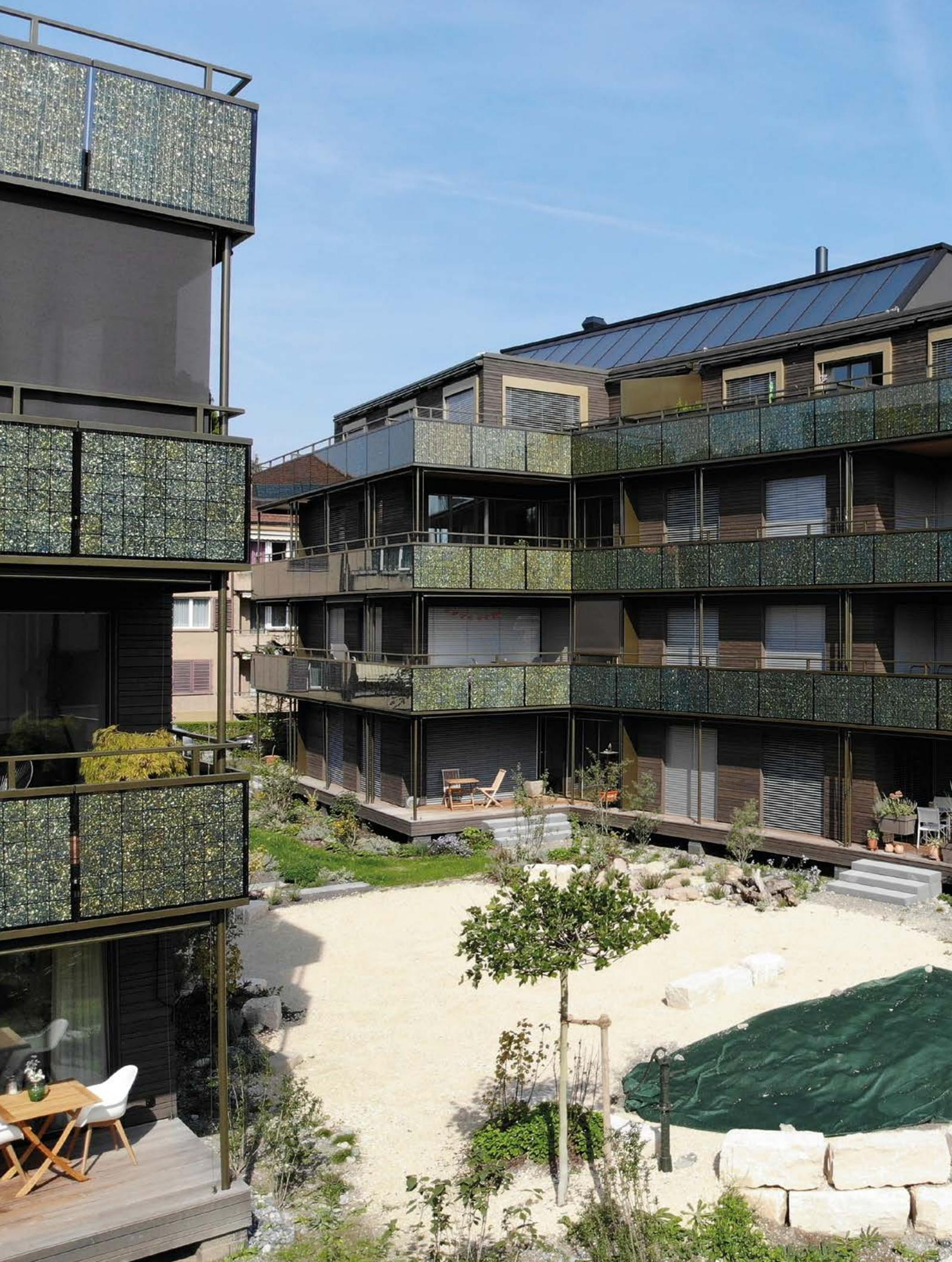
▲ Lotissement à Zurich Altstetten | Balustrades solaires avec panneaux bi-verre faits sur mesure
